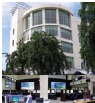
Foto Pedoman 2. Gedung Operasional BMKG dan Ruangannya "Warning Center".
