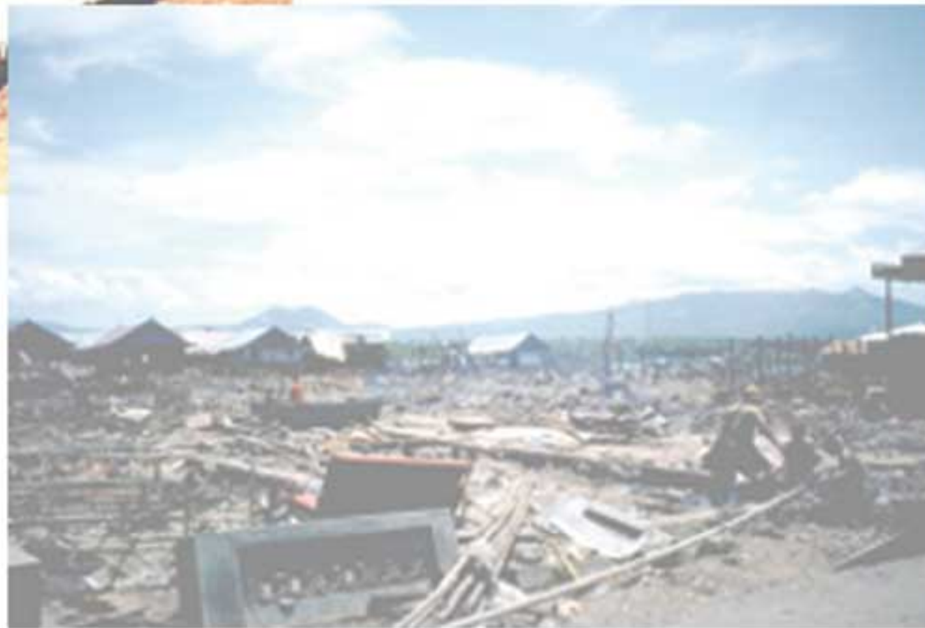
Kerusakan pada Pemukiman (Maumere, 1992)
